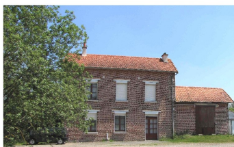
1 L'ancienne gare de Matringhem (1893)
